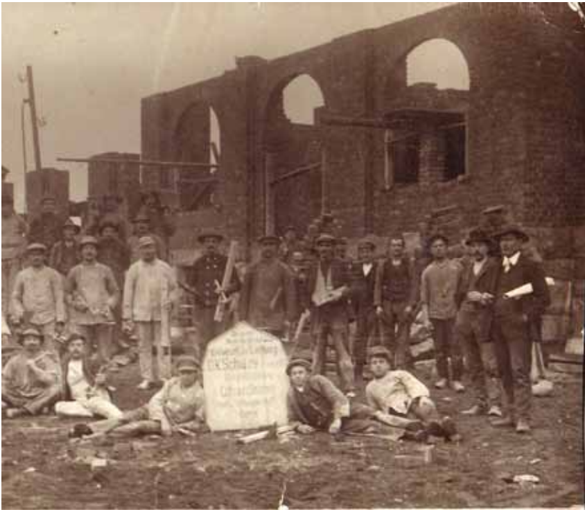
Das älteste verfügbare zeigt den Bau der Herz-Jesu-Kirche. Bereits sichtbar sind hier die innen liegenden Bögen. Die Außenmauern wurden später errichtet.
