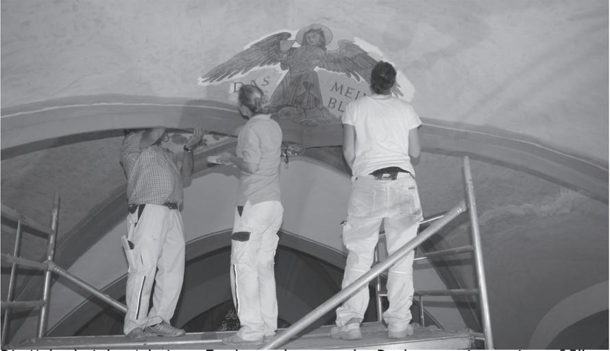
Die Maler bei den Arbeiten. Zur Instandsetzung der Decke war eigens ein großflächiges Gerüst aufgebaut worden.
